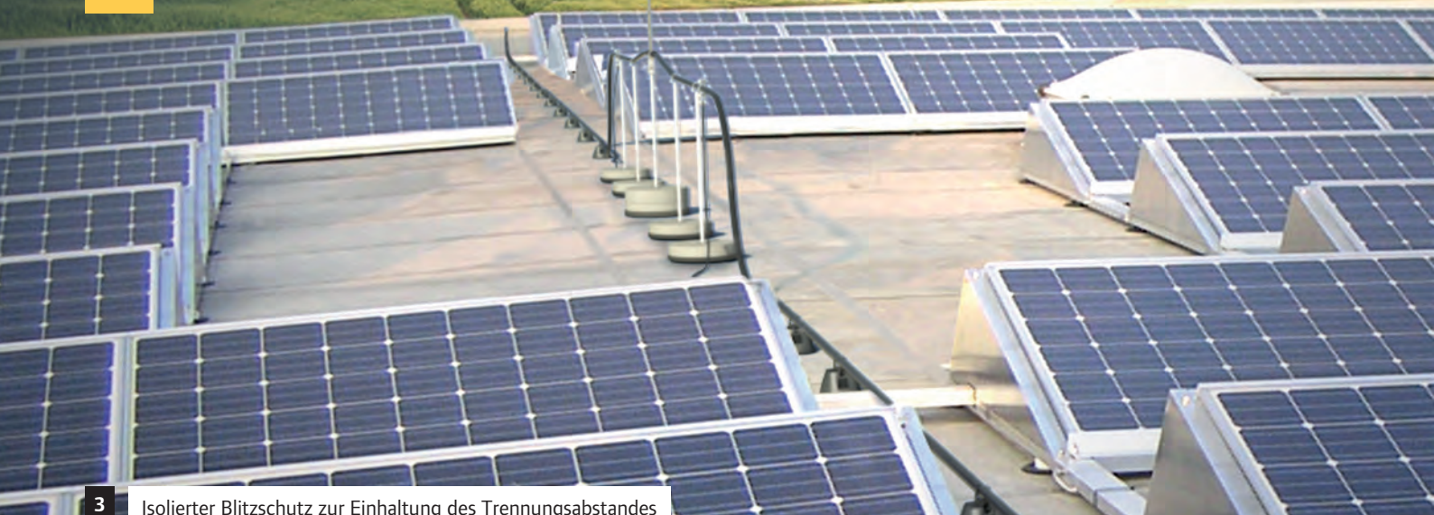
3 Isolierter Blitzschutz zur Einhaltung des Trennungsabstandes
