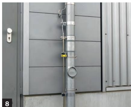
Blitzschutzableitung an einem Regenfallrohr
