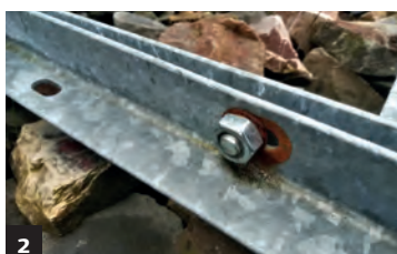
2 Durch eine verzinkte Unterlegscheibe und eine Edelstahlmutter ist ein ungünstiges Flächenverhältnis entstanden.
