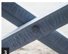
3 Leichter Weißrost an einer feuerverzinkten Konstruktion.
